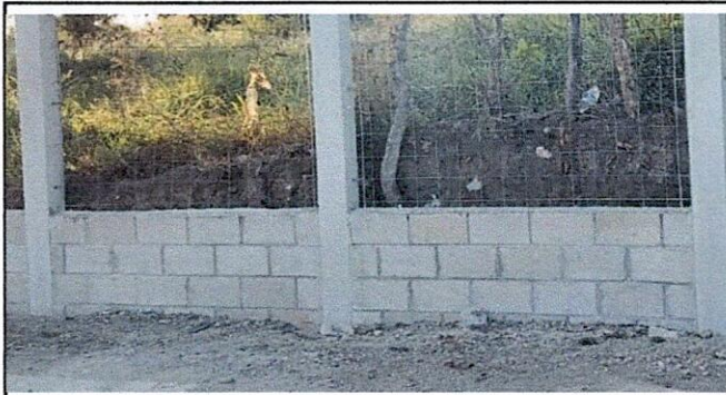
Foto 1: Mejoramiento de cercamiento perimetral: Zanjeo y fundición con armadura de hierro de 64 metros lineales y Levantamiento de Muro con 4 hiladas de block en 53 metros cuadrados
