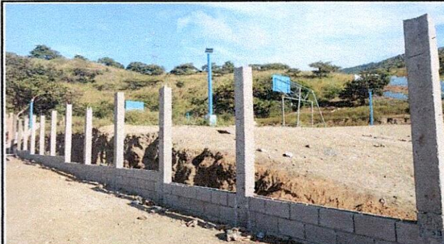
Foto 2: Mejoramiento de cercamiento perimetral: Fundición de 2 columnas 25 x 25 de 4 metros y fundición de 26 columnas de 15 x 20 de 4 metros
