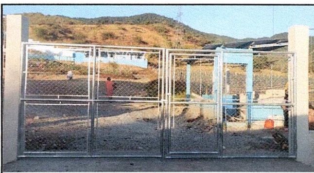
Foto 6: Elaboración y colocación de Portón
