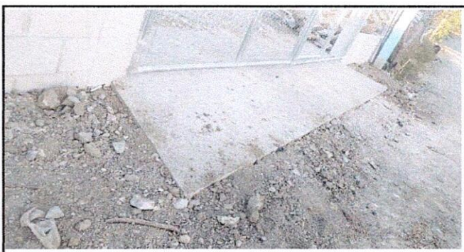
Foto 5: Mejoramiento del acceso peatonal: Fundición de 45 metros de rampa de concreto
