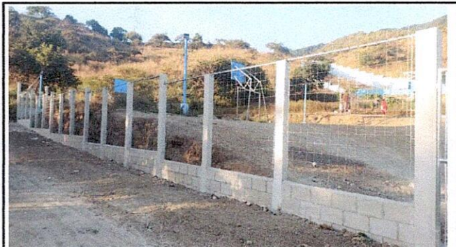
Foto 3: Mejoramiento de cercamiento perimetral: Colocación de 64 metros de electro malla
